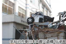
気仙沼市東日本大震災遺構・伝承館
